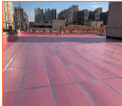
6 조인트 테이프 시공
