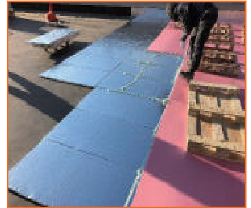
4 상부 보양재 시공
