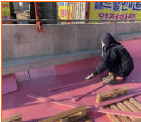
5 파라펫구간 진공단열재 시공 및 보양
