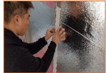
4 시공불가부위 타단열재 부착
